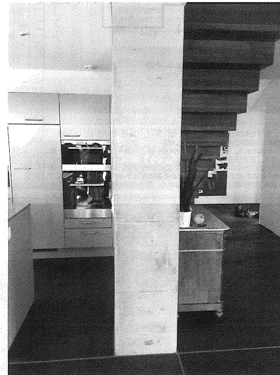
階段を支える壁を新設。蓄熱容量を考えこちらもコンクリートそのままの仕上げにした。右側が木製階段。
