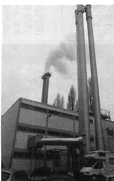
周辺地域3万世帯分の給湯・暖房を賄うヒートステーション。フライブルク市内にはこのような地域暖房施設が160カ所ある。フライブルク市の熱需要のうち36%が地域暖房施設で賄われている。コジェネレーションシステムを年間約6000時間稼働させ熱を作りながら、市内の55%の電気を供給している。ちなみにフライブルク市は原発による電力ゼロの街。残りの45%は、40%がスイスの水力発電、5%が太陽光発電で生産された電力で賄われている。
